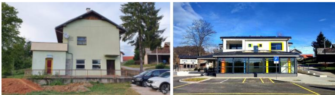
Slika 43 Područni vrtić u Bariloviću (izgled objekta prije i poslije)
