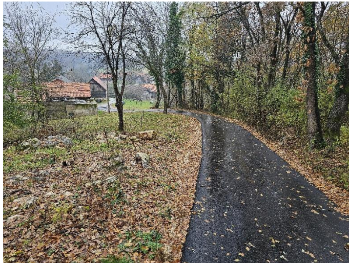
Slika 61 Asfaltiranje nerazvrstane ceste
