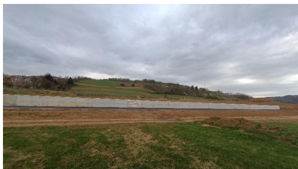
Slika 59 Pješačka staza i potporni zid u Donjem Velemeriću
