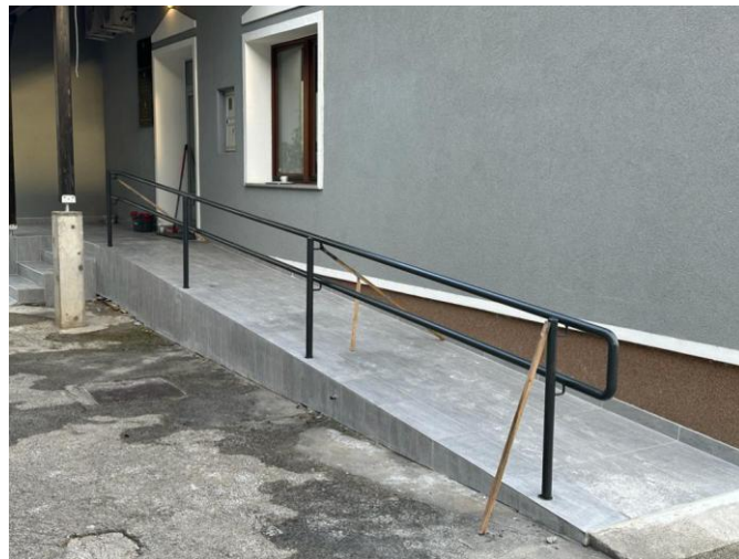
Slika 62 Rampa za osobe s invaliditetom ispred zgrade Općine
