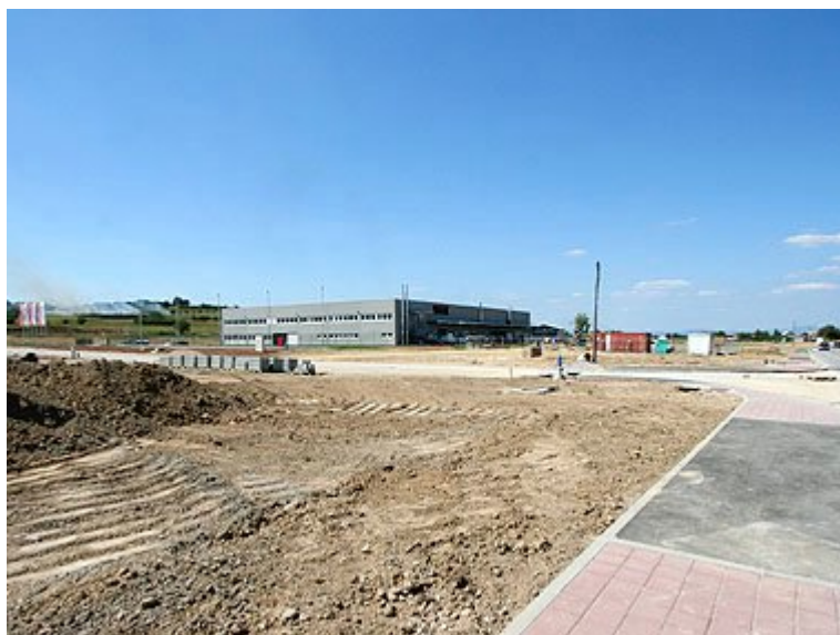
Slika 1. Postojeća izgradnja u obuhvatu Plana
